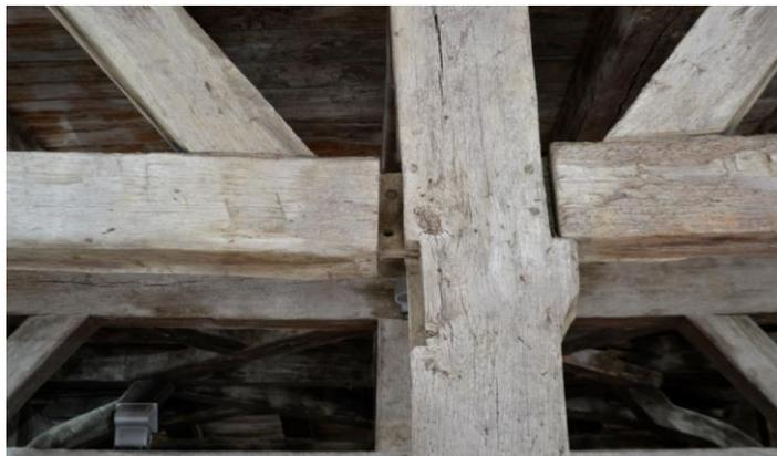
Fig. 5 : Rupture de chevilles dans un assemblage tenon-mortaise
